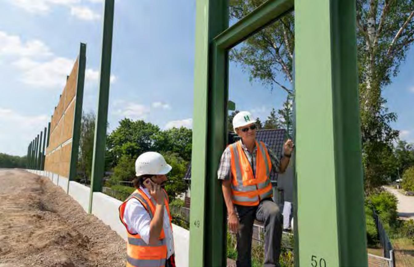
**Polier Frank Reiter und Bauleiter Said Nasser kontrollieren die Montage der Lärmschutzwände längs der Anschlussstelle Birkenwerder.**
