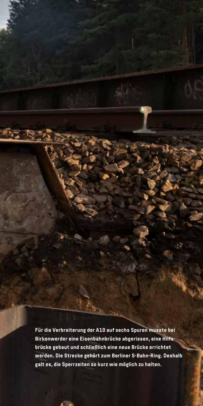
Für die Verbreiterung der A10 auf sechs Spuren musste bei Birkenwerder eine Eisenbahnbrücke abgerissen, eine Hilfsbrücke gebaut und schließlich eine neue Brücke errichtet werden. Die Strecke gehört zum Berliner S-Bahn-Ring. Deshalb galt es, die Sperrzeiten so kurz wie möglich zu halten.
