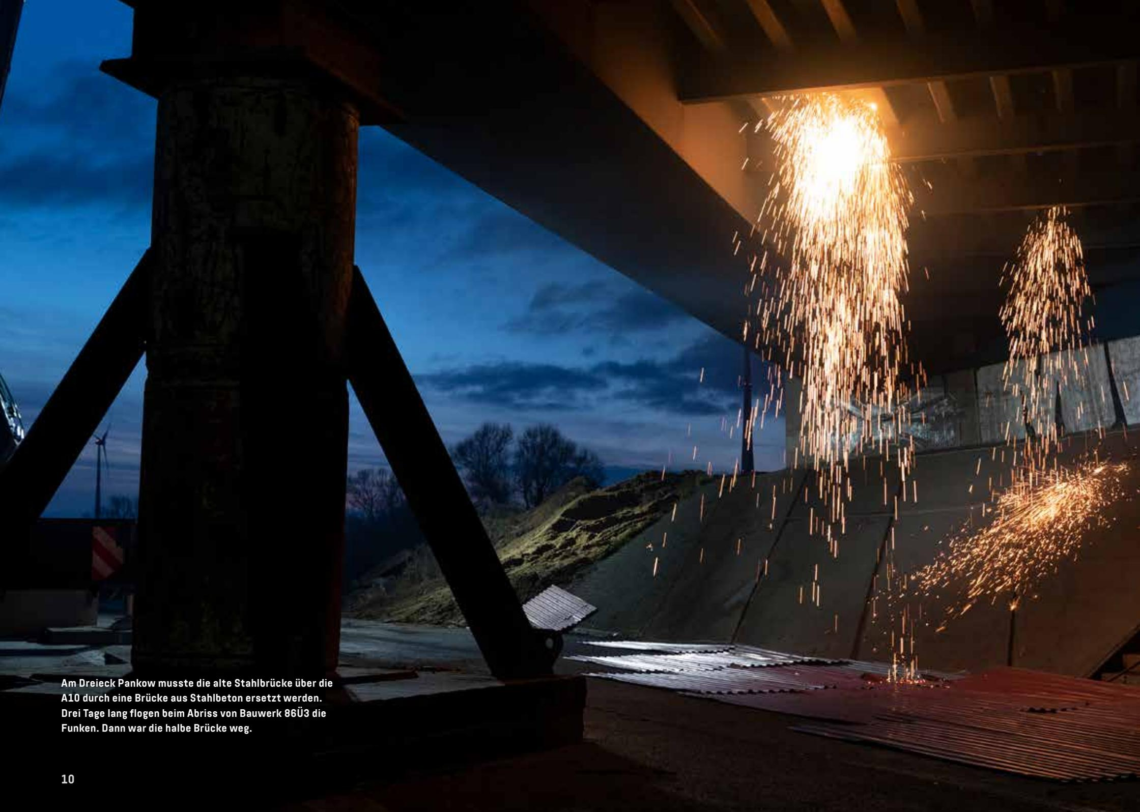
Am Dreieck Pankow musste die alte Stahlbrücke über die A10 durch eine Brücke aus Stahlbeton ersetzt werden. Drei Tage lang flogen beim Abriss von Bauwerk 86Ü3 die Funken. Dann war die halbe Brücke weg.
